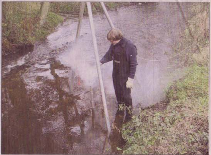
Jede Menge Nebel: Jochen Dirksmeyer füllt flüssigen Stickstoff in die Rohre im Gewässergrund. Foto: Kalff
